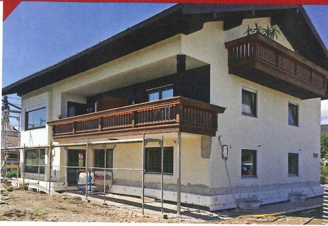
**6** Bei dem Pilotprojekt in Traunwalchen konnten gegenüber der zertifizierten Systemvariante noch einige Detailpunkte verbessert werden. So wurden zum Beispiel für die Riegel und Pfosten FJI-Träger anstatt Massivholzern verwendet. Gut zu erkennen ist ganz links neben dem Balkon das vorgelagerte Blumenfenster in EG und OG.
